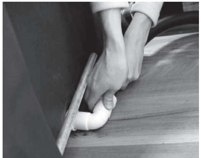
2. Abziehen des Abflussschlauches
